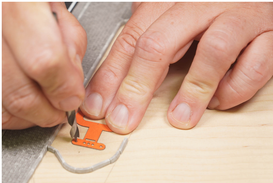
Abbildung 14: Die Spitze des Holzbohrers wird in ein Loch der Anzeichenhilfe gesetzt, um den Punkt zu kornen
